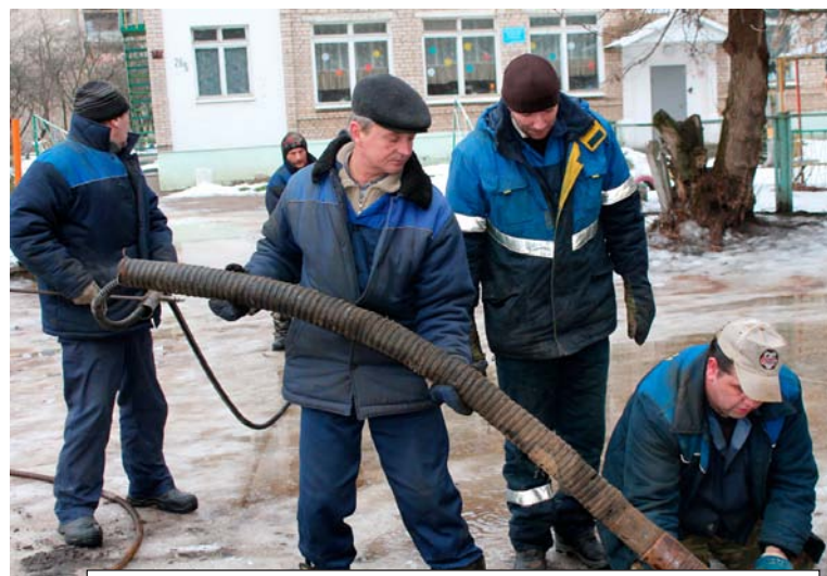
Техническое обслуживание канализационной сети проводится возле детского сада №9, ул. М.Горького, 26Б
