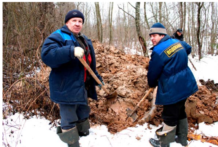
Устранение аварийной ситуации на водопроводной сети возле деревни Кузьмино. На снимке: слесари аварийно-восстановительных работ С.Н.Коршунов (слева) и А.А.Симонов
